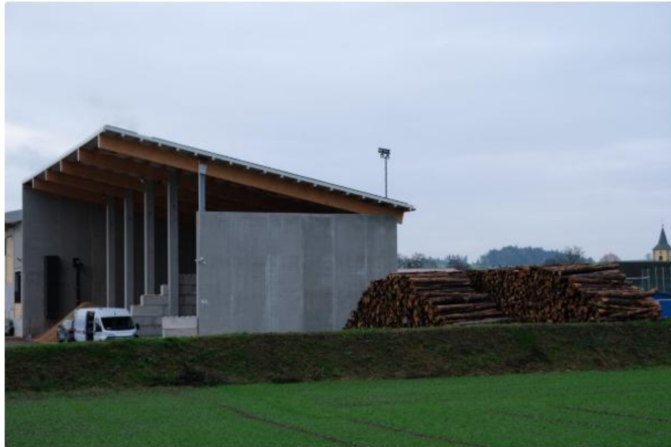
Im Gewerbegebiet Tremmersdorf entstand ein Hackschnitzel-Blockheizkraftwerk für Holzverstromung und für ein Nahwärmenetz. Eine Warmwasserleitung der Firma „Fernwärme-Schmid“ versorgt bereits 32 Wohngebäude in Tremmersdorf, das Kloster Speinshart und den Speinsharter Klostergasthof. Erweiterungskapazitäten sind vorhanden. Foto: Robert Dotzauer
