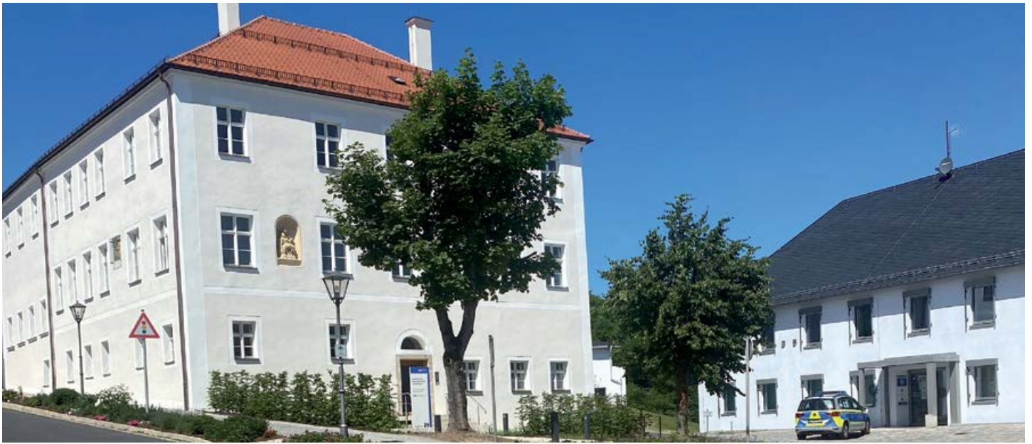
Altes Landratsamt und Polizeiinspektion © Emma Engelmänn
